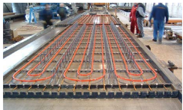
Verlegung der Rohre in Elementdecken im Betonwerk
